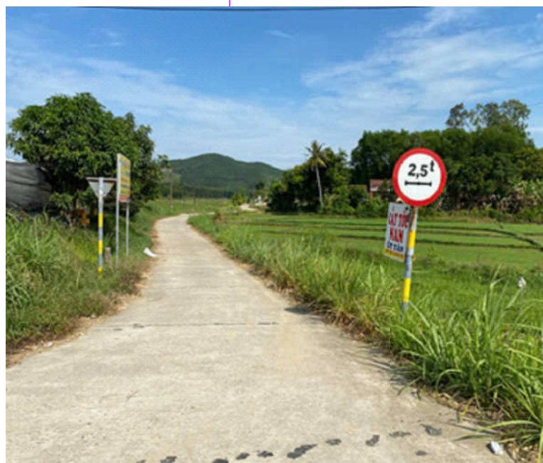
TUYẾN ĐƯỜNG BT NÔNG THÔN
